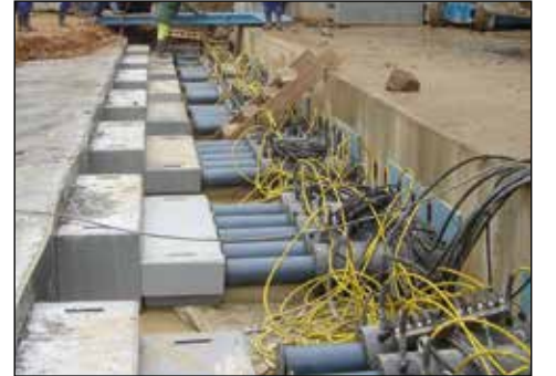
▲ Beton itme: Tünel parçalarını ray hattının altına hidrolik güçle itmek için çok noktalı senkronize sistem.
